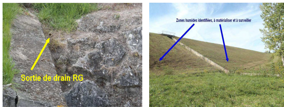
Figure 1 : Sortie de drain non aménagée pour la mesure (barrage 7) – Présence de deux zones humides et sorties de drains non retrouvées (barrage 8)
