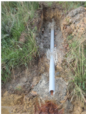
Figure 2 : Recherche et reprise des sorties de drains sur le barrage 3
