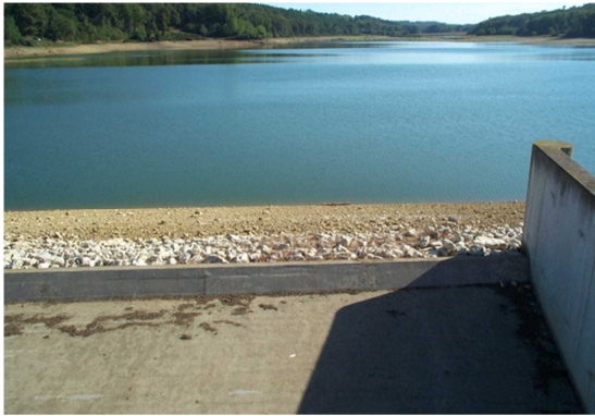
Figure 5 : exemple de seuil sur un ouvrage de classe B en 40 susceptible d'être à redimensionner.
